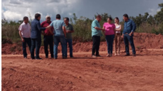
Gil Pereira visitou neste sábado (23/04/22), ao lado do prefeito Juvenal Alves, o Ju, da sua competente equipe administrativa e dos vereadores, as obras de pavimentação asfáltica em Luislândia
