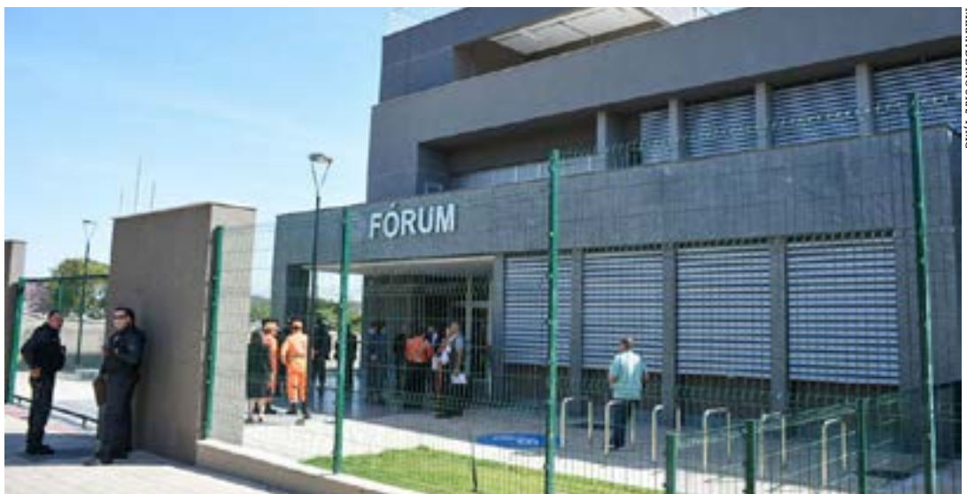
Novo fórum de Francisco Sá conta com instalações modernas para dar ainda mais celeridade e eficácia ao trabalho de magistrados e servidores
