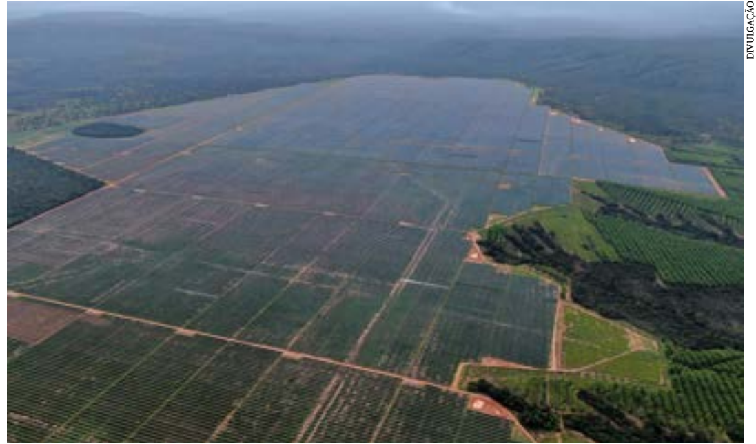
O parlamentar destacou que começam este ano as obras deste parque fotovoltaico gigante da multinacional espanhola Solatio (potência de 2,1 GW), trazendo impacto inédito de desenvolvimento para Buritizeiro e todo o Norte de Minas
