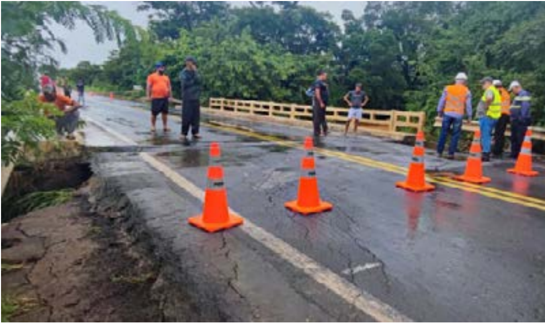
Chuvvas comprometeram encabeçamento da estrutura na rodovia, no trecho entre Janaúba e o entrocamento da BR-251
