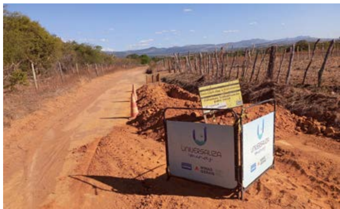
Investimentos de R$ 2 milhões do Universaliza Minas vão atender 1,6 mil moradores com a instalação de 40 mil metros de redes de distribuição
