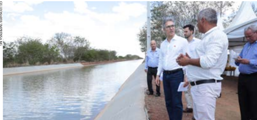
Intervenção no principal canal do projeto para conter vazamentos e melhorias nas estradas que passam pela região asseguram maior segurança para os produtores e abastecimento de água para a população
