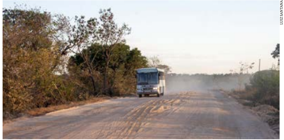
Trecho de 58 quilômetros de estrada de terra seria entrave ao desenvolvimento de municípios entre o Jequitinhonha e Norte de Minas
