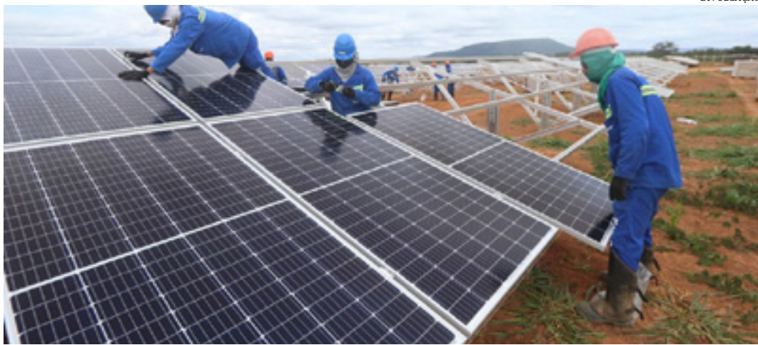
A instalação de painéis fotovoltaicos, no Norte de Minas
