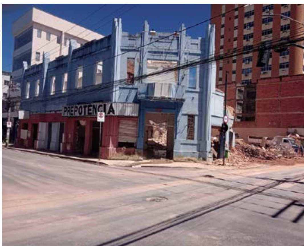
A demolição do prédio histórico
