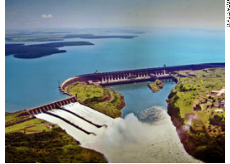
Usina Hidrelétrica de Itaipu
