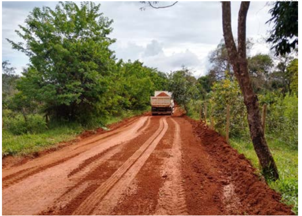
Melhoria de estradas rurais, em comunidade de Montes Claros
