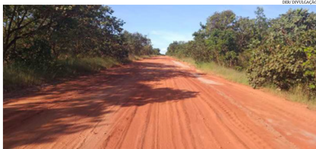
Contrato contempla pavimentação de 73,14 quilômetros e construção de três pontes; acordo anterior é passível de penalidades previstas em lei
