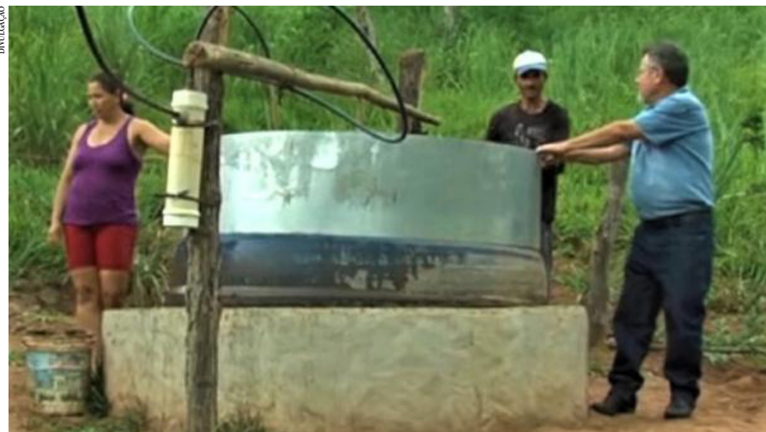
Equipamentos fornecem gás para uso doméstico e biofertilizante, a partir de esterco bovino
